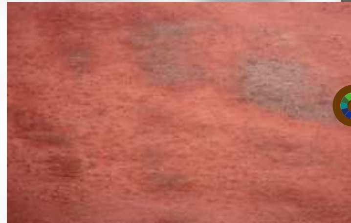
23. 铁锈a Rust A
